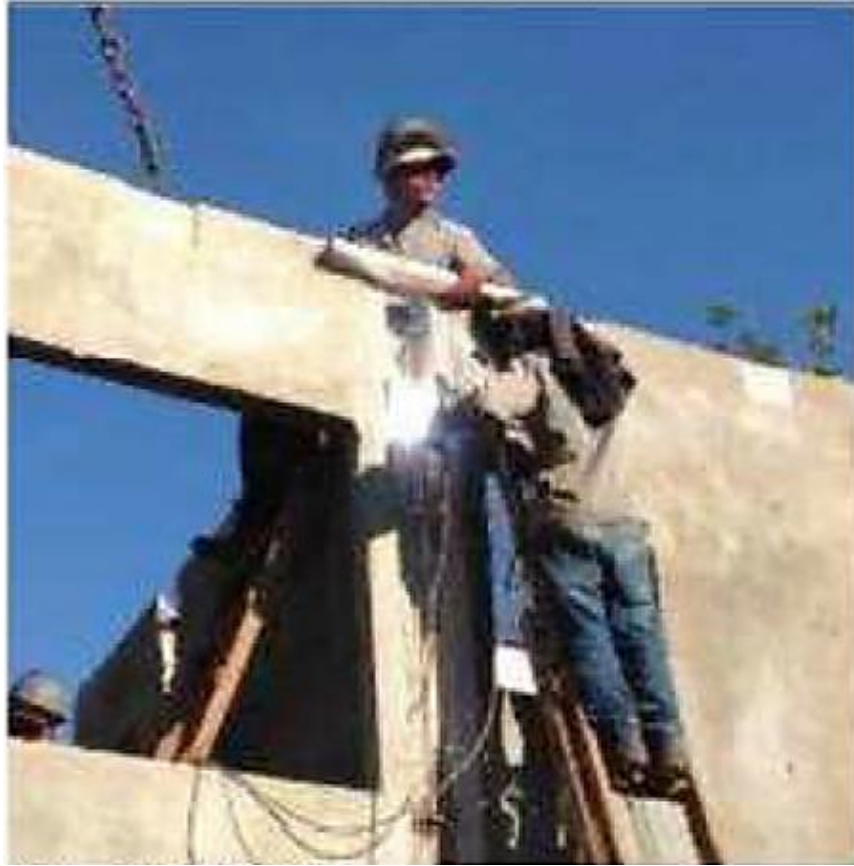
Figura 4 - Solda dos painéis
