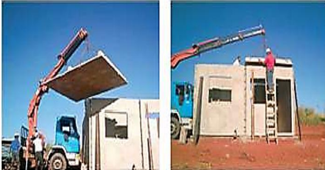
Figura 6 - Içamento e posicionamento da laje
