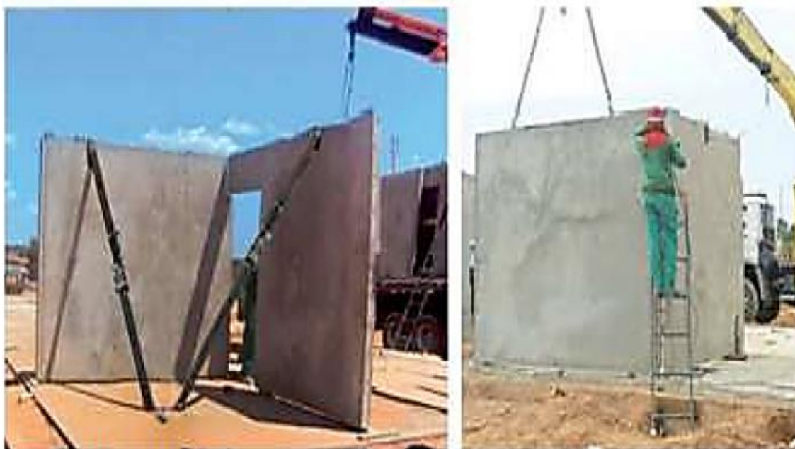
Figura 3 - Montagem e assentamento da placa
