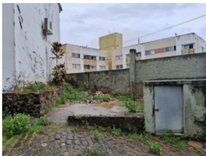
Figura 42 — Área atrás do Bloco C
