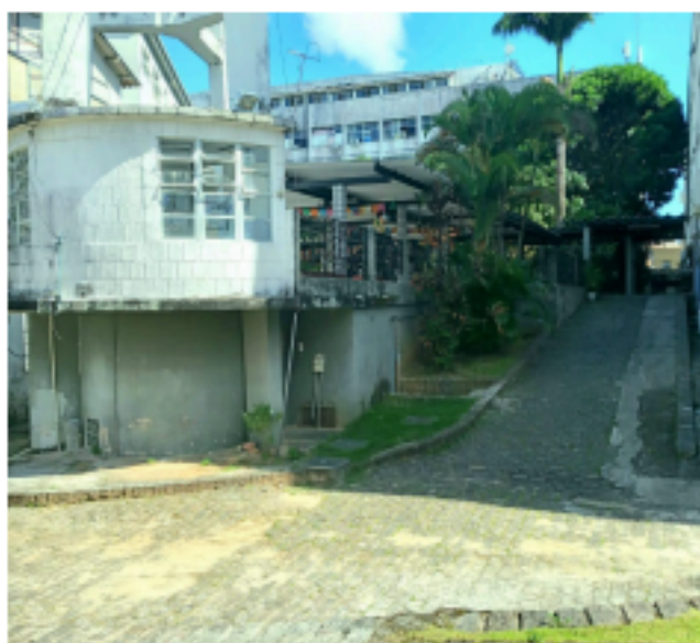
Figura 07 — Rampa de Acesso ao Bloco D
