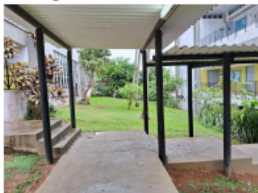
Figura 12 — Pátio do Bloco O
