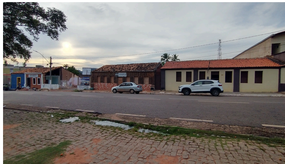
Figura 24: Casarões na Praça Joaquim Nogueira Paranaguá:
