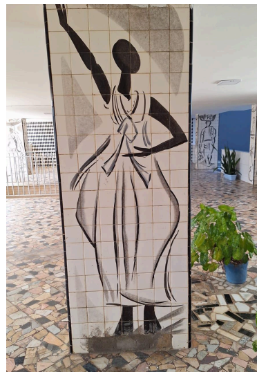
Figura 40 - Painel 6 localizado no playground do Edifício Avany.
