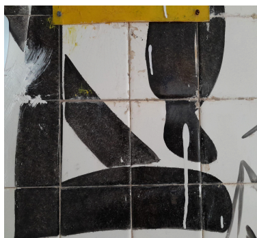
Figura 50 - Manchas e resquícios de tintas no painel 9.
