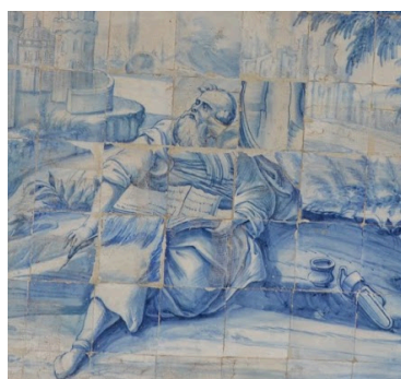
Figura 84 – Detalhe da desordem em um dos painéis do claustro.
