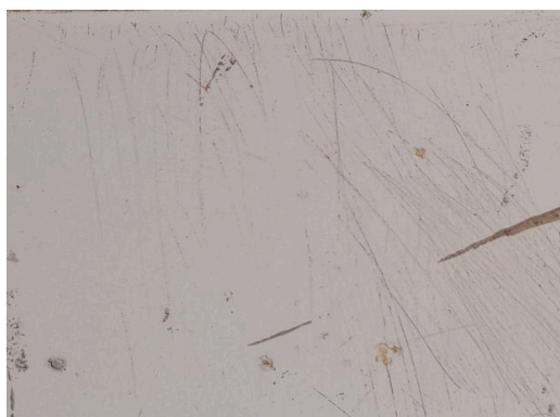
Figura 48 - Presença de riscos no vidro do painel 2. Fonte: Acervo pessoal, 2024.
