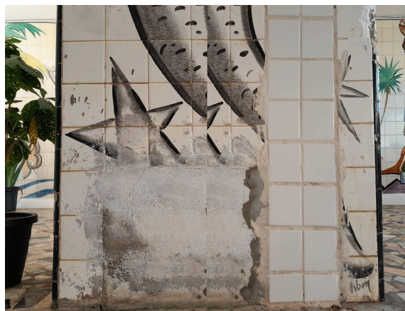
Figura 63 - Detalhe de uma das faces do painel 6 que representa o preenchimento da lacuna com argamassa e com azulejos fora do padrão do painel.
