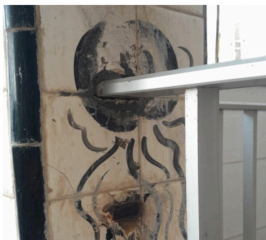
Figura 68 - Imagem da face do painel 2 que demonstra duas aberturas feitas para a colocação do corrimão.
