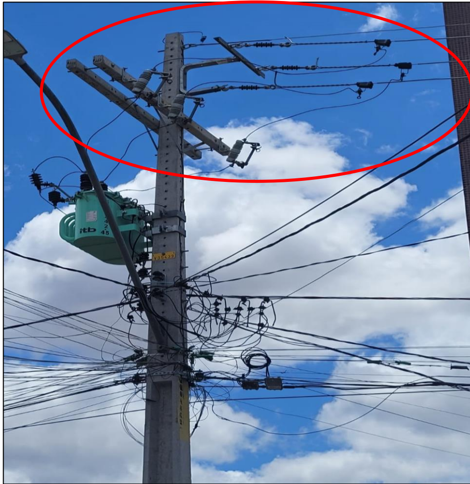
Figura 2.5 – Estrutura de uma rede compacta.
