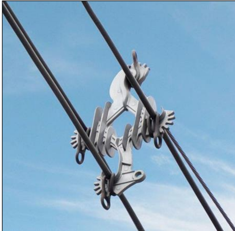
Figura.2.4 - Espaçador Losangular de uma Rede Compacta.
