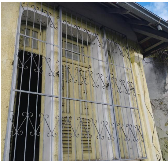
Figura 16 – Janela da fachada
