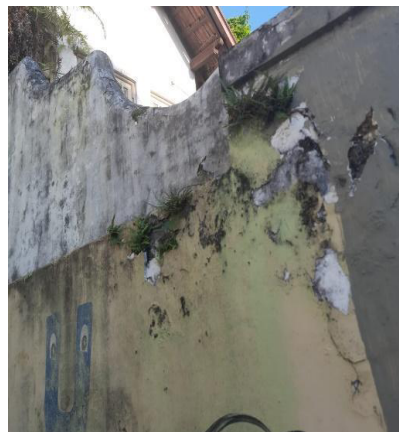
Figura 11 – Vegetação no muro
