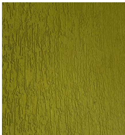
Figura 21 – Acabamento do reboco interno
