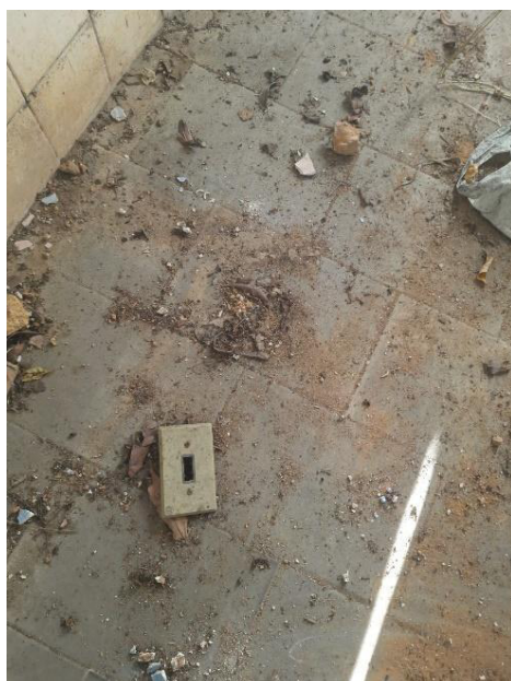
Figura 25 – Piso do banheiro
