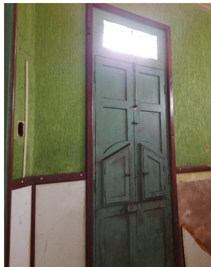
Figura 17 – Porta para a fachada
