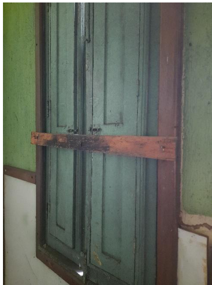
Figura 32 – Ripa fechando a janela
