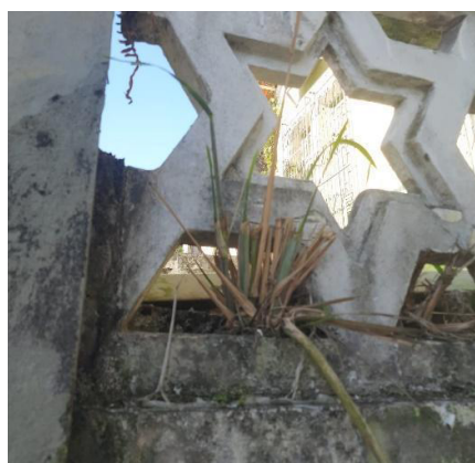
Figura 12 - Vegetação no guarda-corpo
