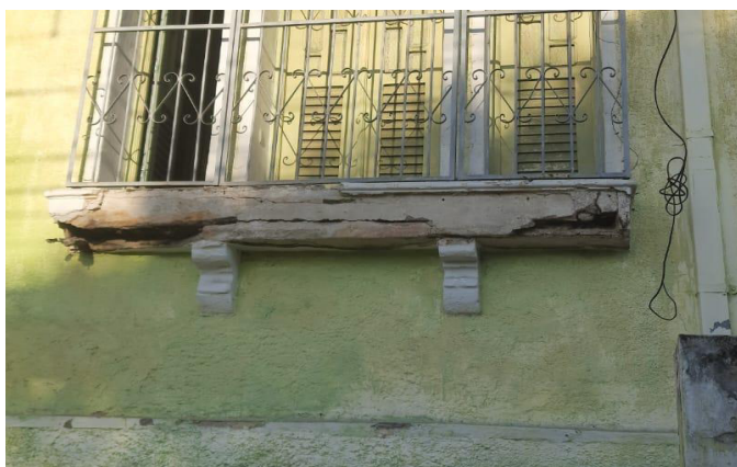
Figura 07 – Desagregação da jardineira
