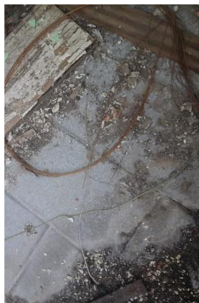
Figura 26 – Piso da copa e cozinha
