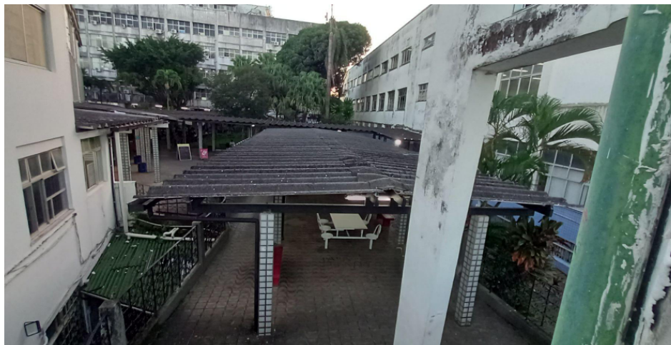
Figura 03 - Telhado atual (vista frontal)
