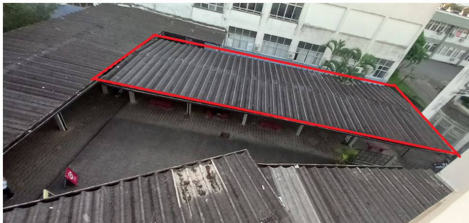
Figura 06 - Telhado atual (vista do bloco B)
