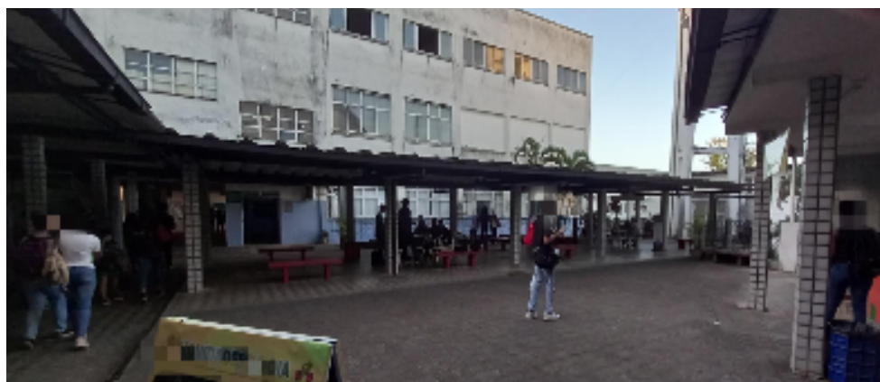
Figura 04 - Telhado atual (vista lateral)
