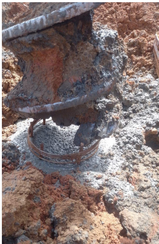
Figura 18- Descendo a ferragem com o auxílio do trado do equipamento
