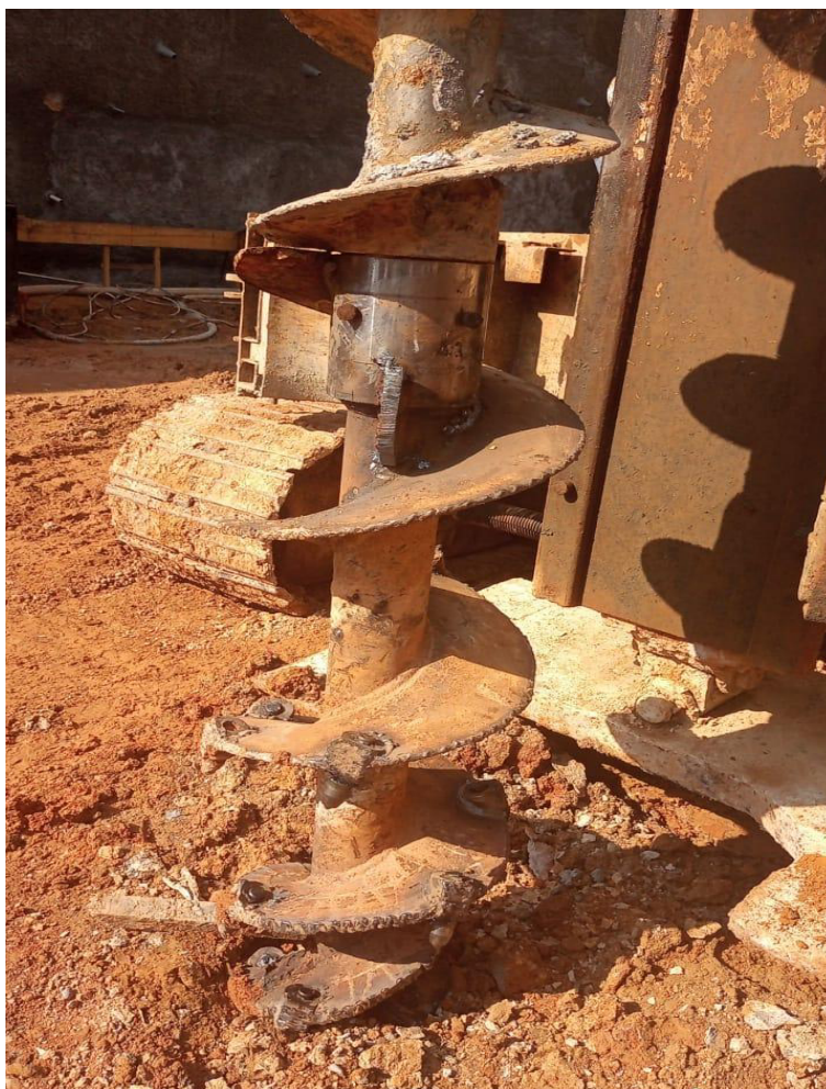
Figura 12- Ponteira, ferramenta utilizada para perfurar.
