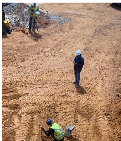
Figura 11- Fazendo a locação da estaca por meio de uma estação total
