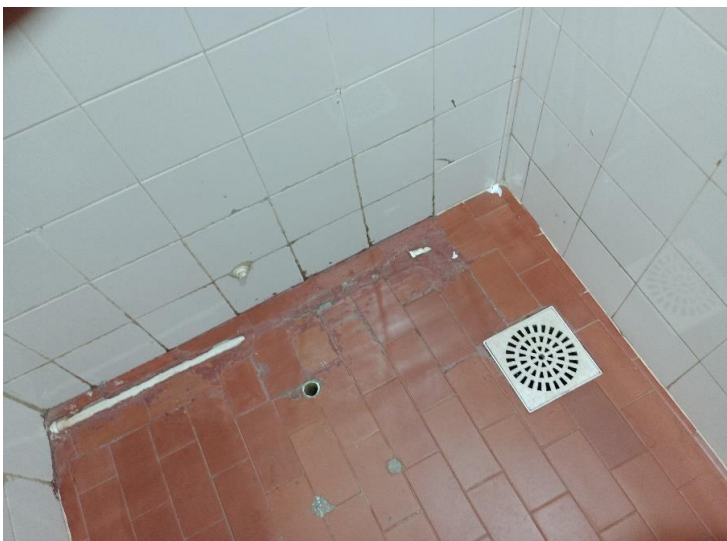
Figura 25: Tubulação isolada com terra, Bloco B, térreo
