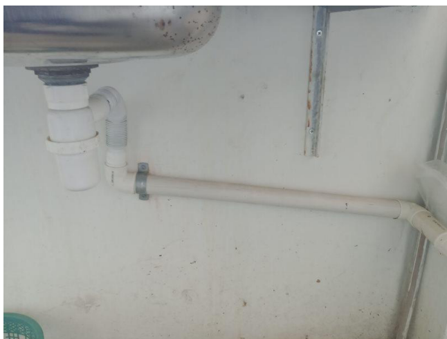
Figura 14: Pia da copa, 5º andar do Bloco A
