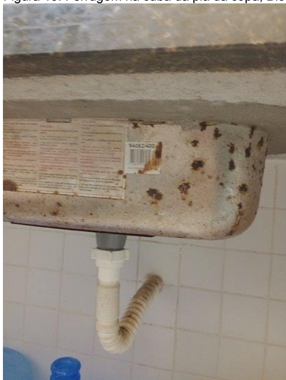
Figura 13: Ferrugem na cuba da pia da copa, Bloco A, térreo– GRAII
