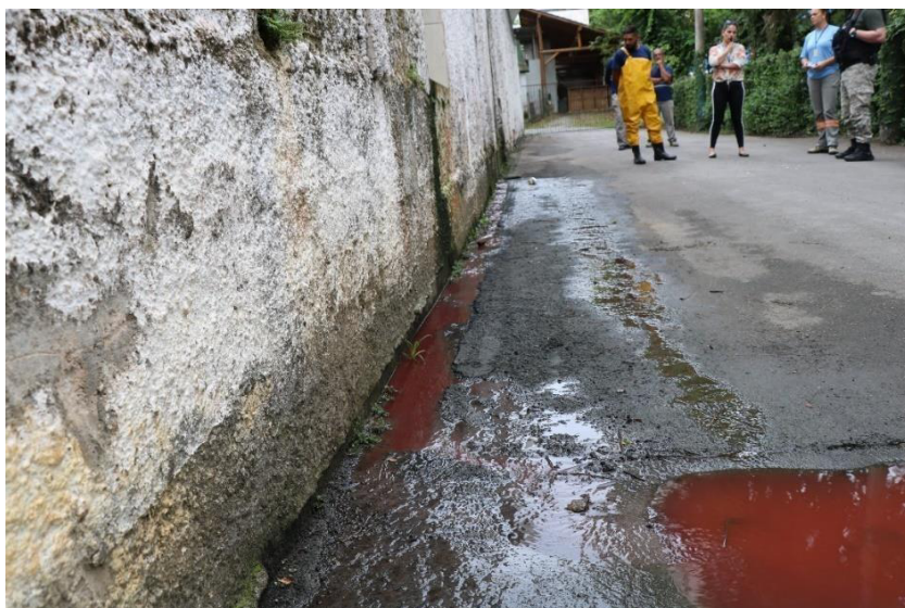
Figura 8: proliferação de limo devido à infiltração de esgoto sanitário
