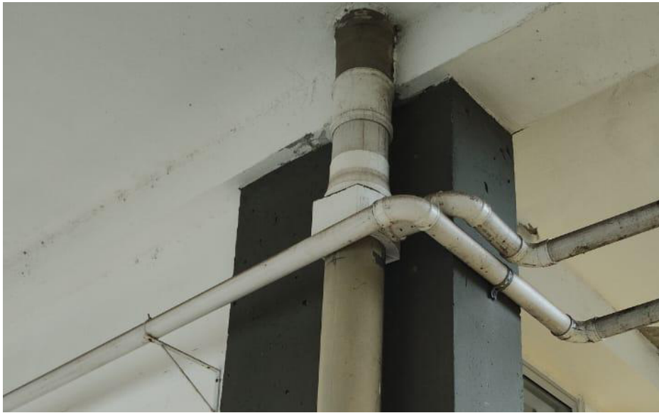
Figura 07: Coletor de efeito Coriolis utilizado no projeto
