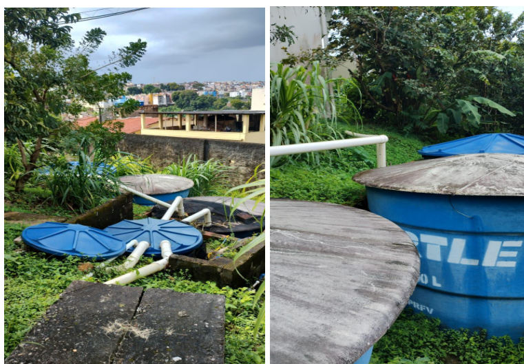
Figura 05: Reservatório de PVC capacidade de 5.000 litros para o armazenamento da Água captada com a ampliação do sistema
