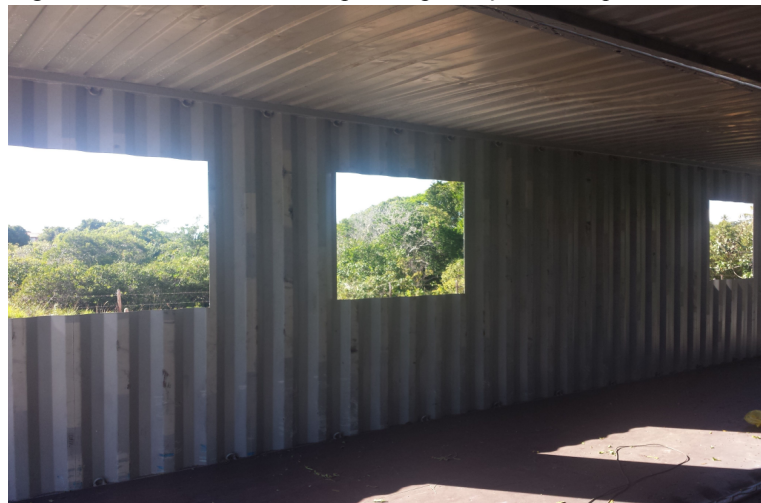
Figura 13: Cortes no contêiner para implantação das esquadrias.
