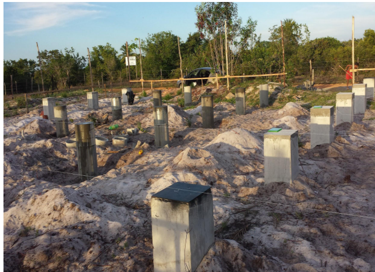
Figura 11: Execução de fundação construção em contêiner
