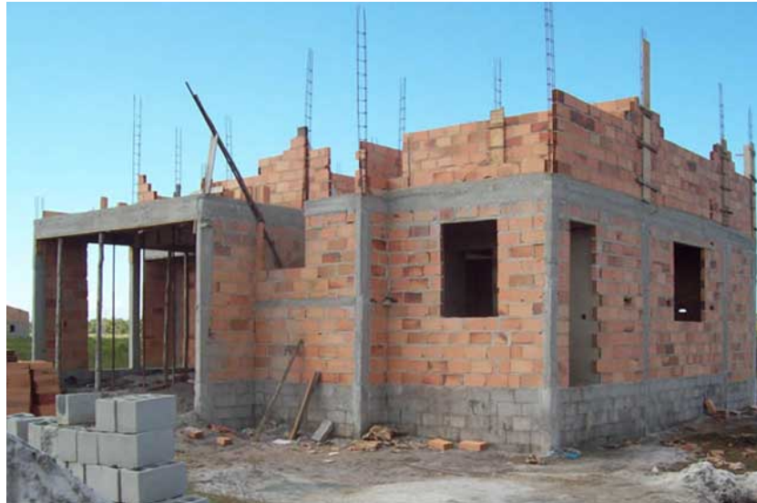
Figura 05: Construção sendo executada em alvenaria.
