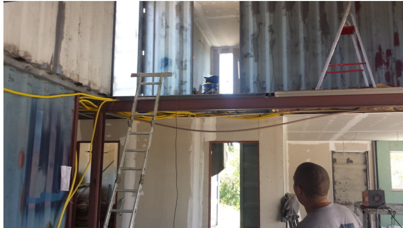
Figura 15: Instalações hidrossanitárias e elétricas.
