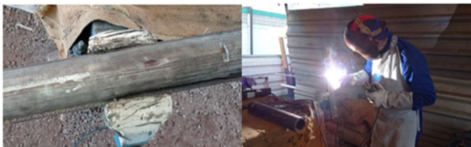
A5- Detalhe do desbaste e recomposição com solda.
