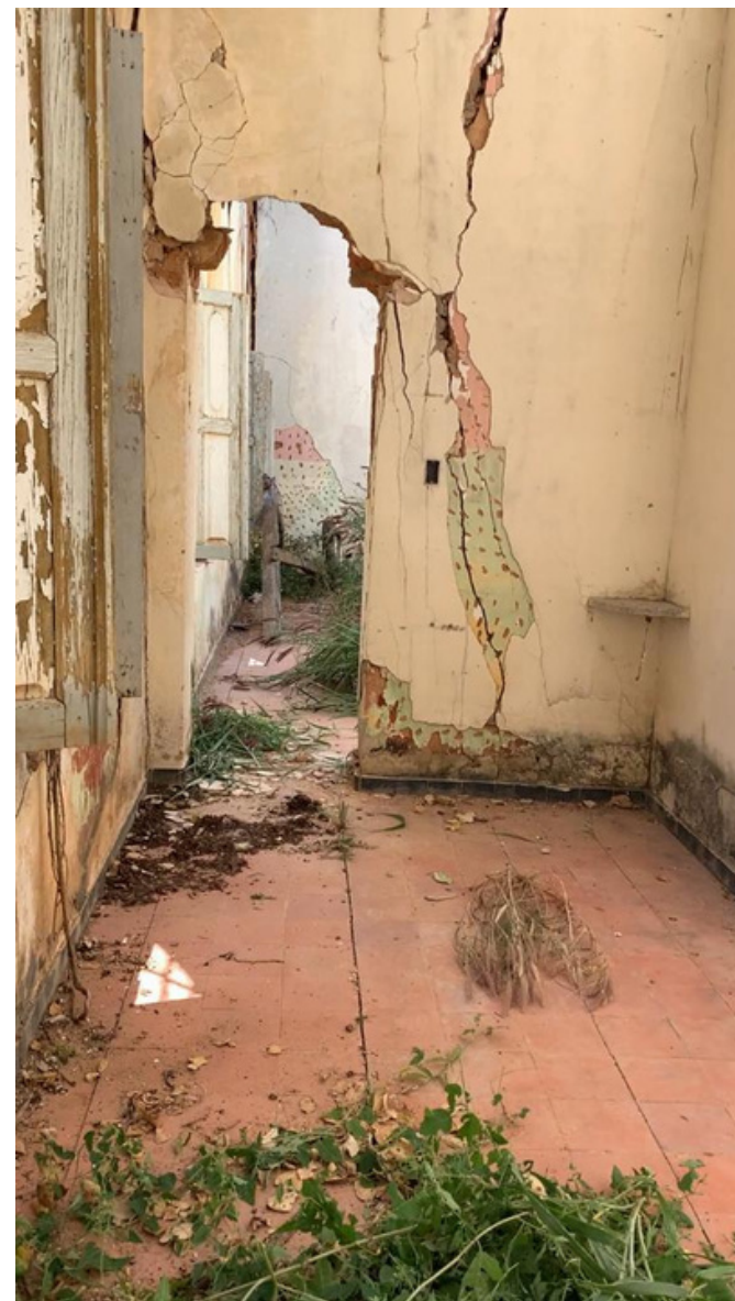
sala G do Abrigo dos Pobres / fonte: Autora, 2021 (figura 83)
