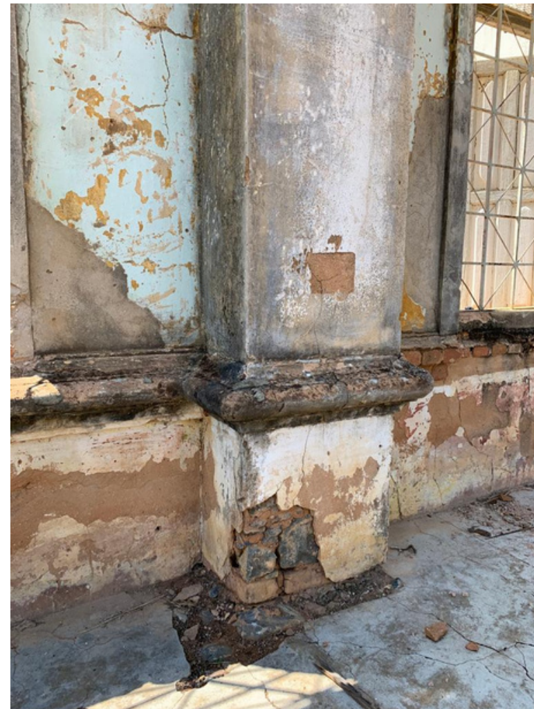
coluna fachada lateral esquerda do Abrigo dos Pobres / fonte: Autora, 2021 (figura 95)
