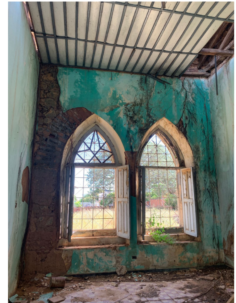
sala L do Abrigo dos Pobres / fonte: Autora, 2021 (figura 93)
