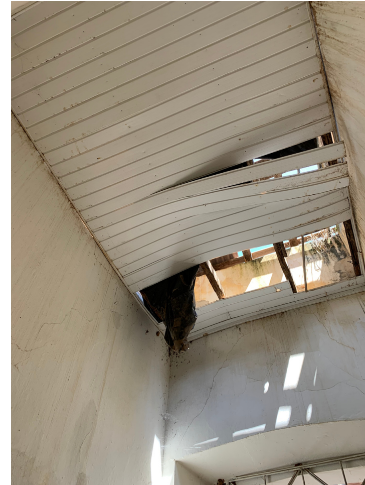
sala a do Abrigo dos Pobres / fonte: Autora ,2021 (figura 54)
