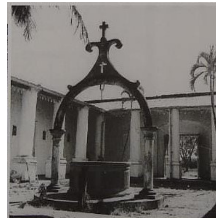
Cisterna no pátio central / fonte: IPAC (figura 16)
