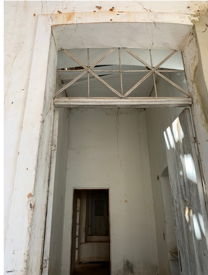
sala a do Abrigo dos Pobres / fonte: Autora ,2021 (figura 52)
