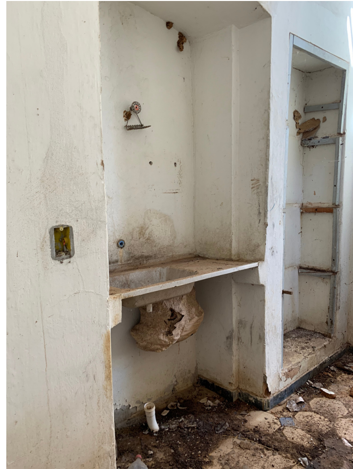
sala a do Abrigo dos Pobres / fonte: Autora ,2021 (figura 53)
