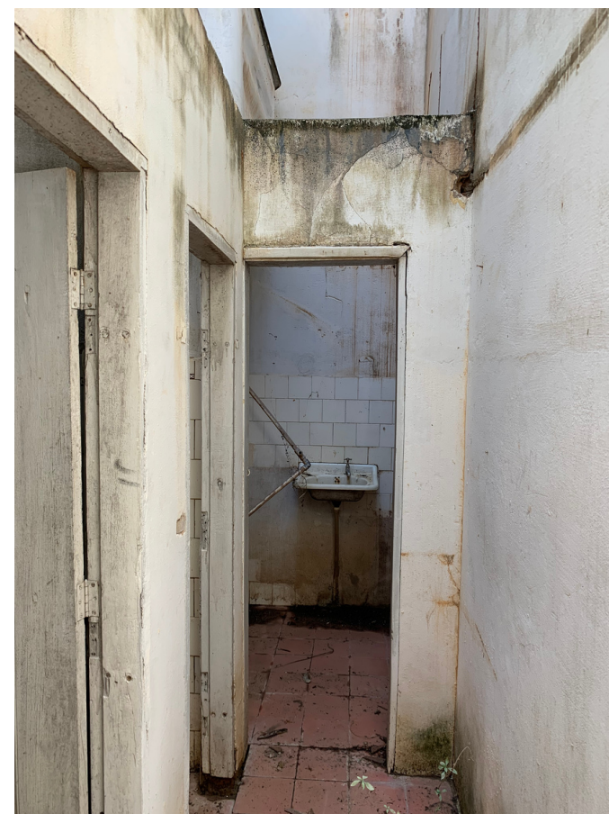
Banheiro do Abrigo dos Pobres / fonte: Autora, 2021 (figura 71)
