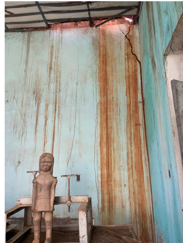
sala L do Abrigo dos Pobres / fonte: Autora, 2021 (figura 91)
