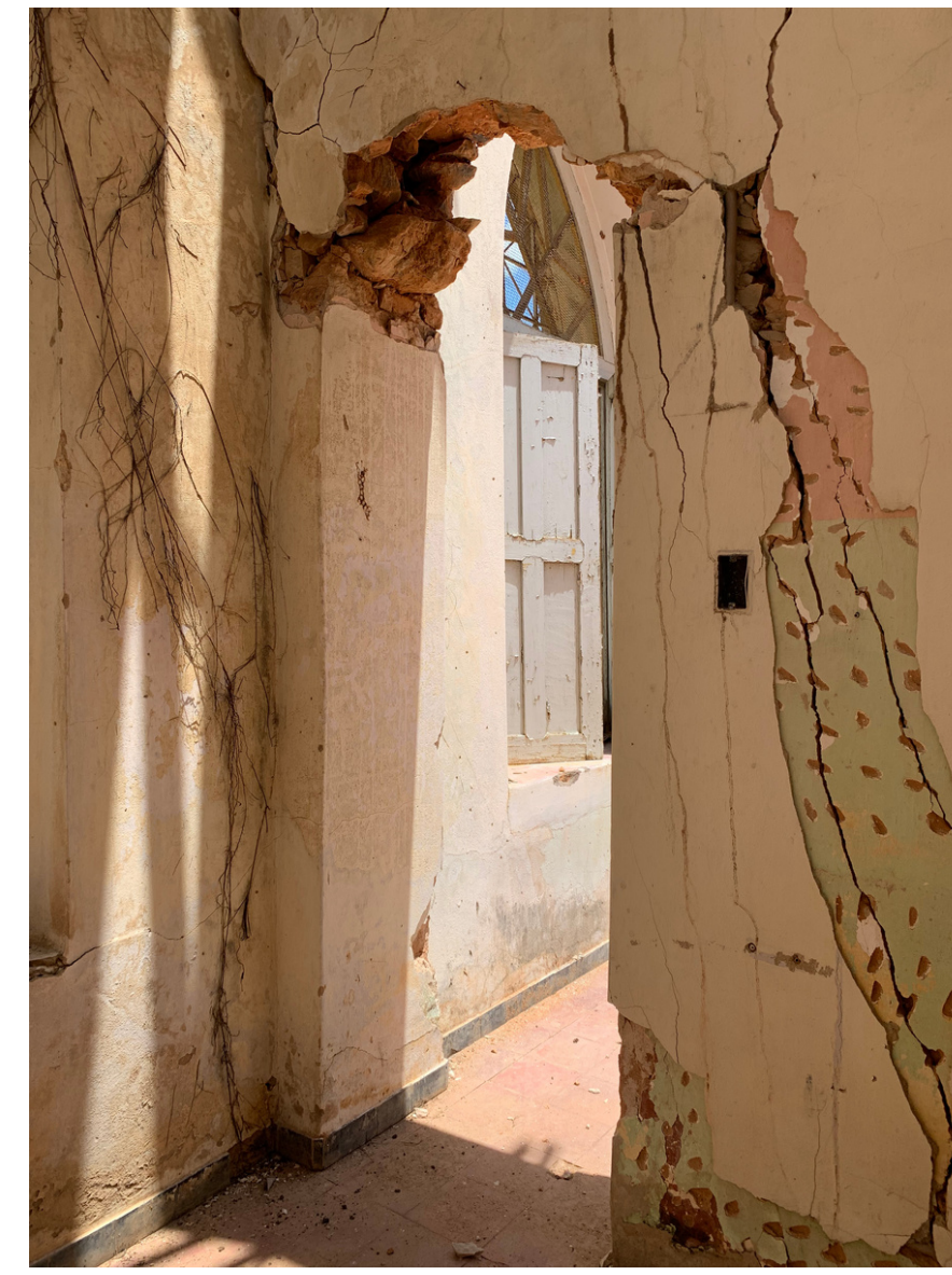
sala G do Abrigo dos Pobres / fonte: Autora, 2021 (figura 84)
