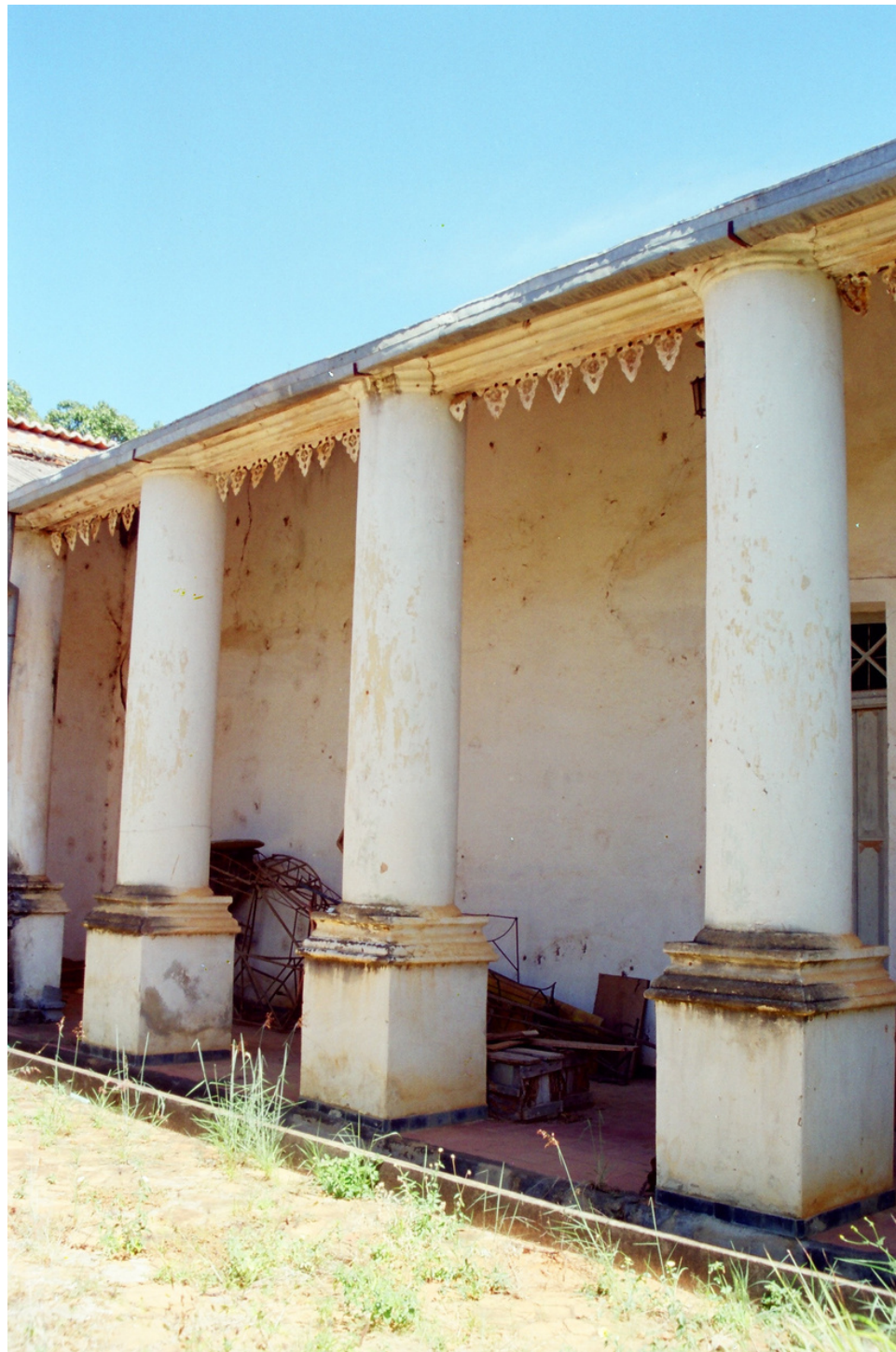
Colunas e corredor interno / fonte: desconhecido, 2006* (figura 23)
