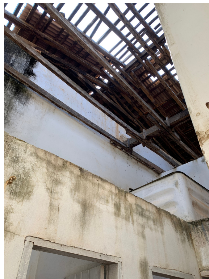
Banheiro do Abrigo dos Pobres / fonte: Autora, 2021 (figura 70)
