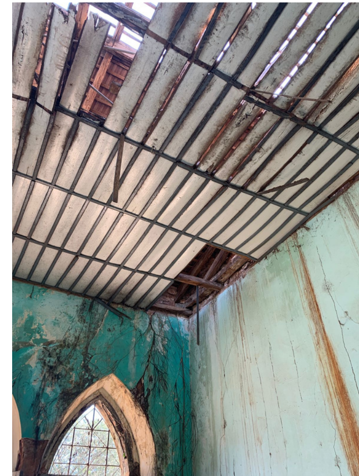
sala L do Abrigo dos Pobres / fonte: Autora, 2021 (figura 92)
