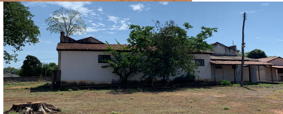
Anexo do abrigo construído na antiga fachada principal / fonte: Autora, 2021 (figura 09)
