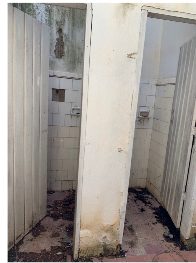
Banheiro do Abrigo dos Pobres / fonte: Autora, 2021 (figura 72)
