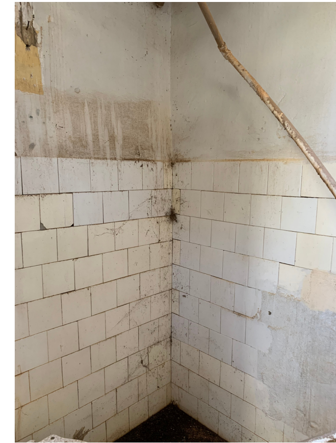
Banheiro do Abrigo dos Pobres / fonte: Autora, 2021 (figura 73)
