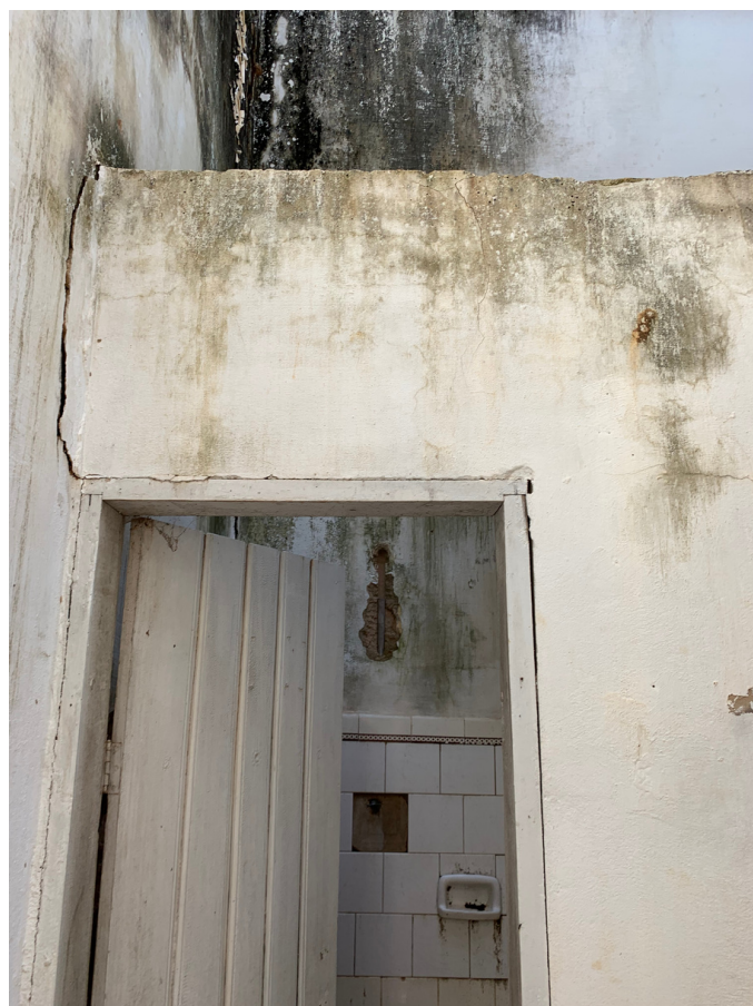
Banheiro do Abrigo dos Pobres / fonte: Autora, 2021 (figura 69)
