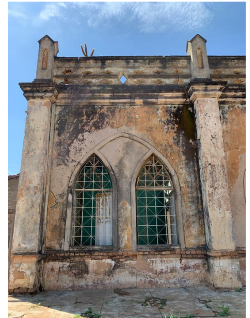
fachada lateral esquerda do Abrigo dos Pobres / fonte: Autora, 2021 (figura 97)
