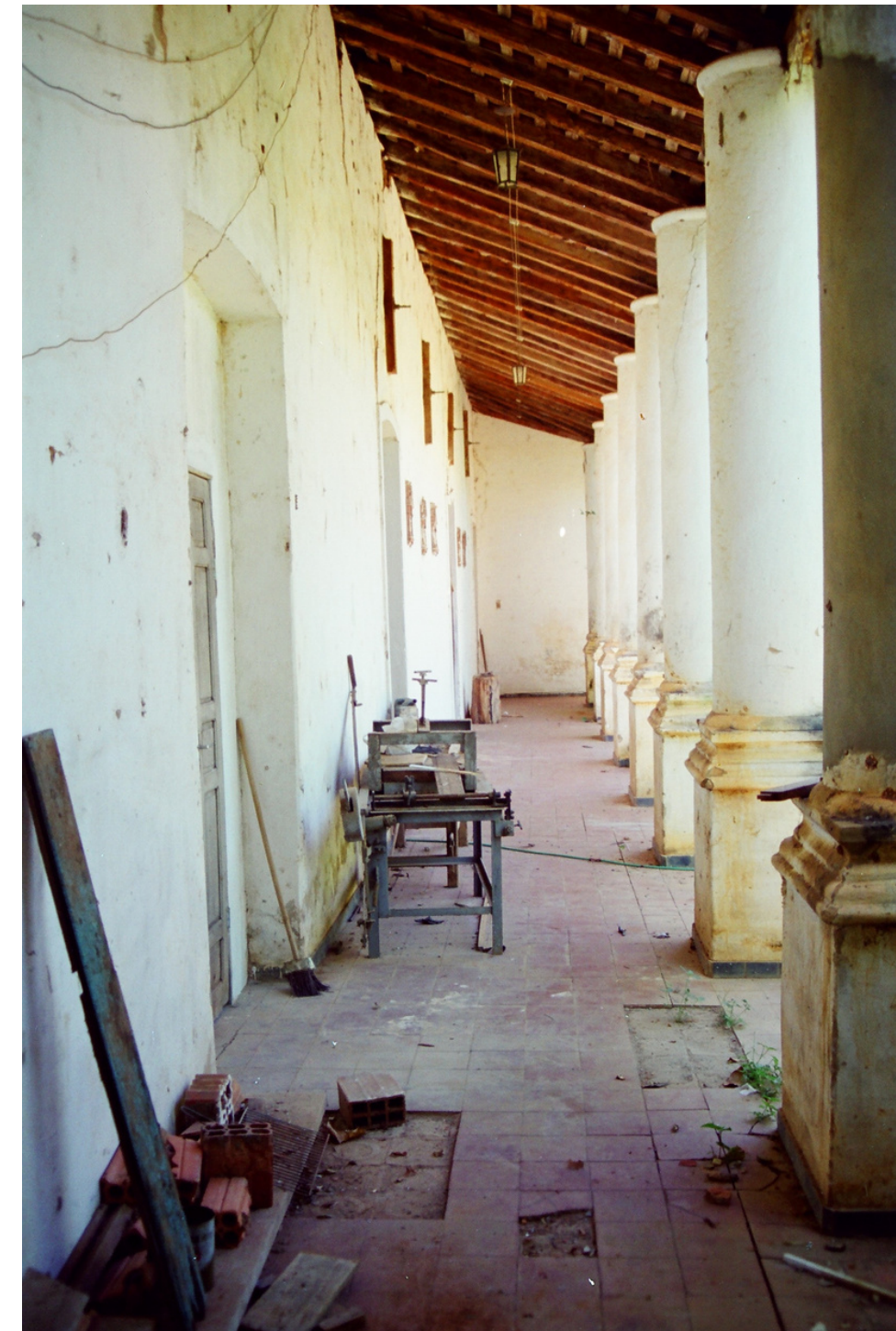
Colunas e corredor interno / fonte: desconhecido, 2006* (figura 25)
