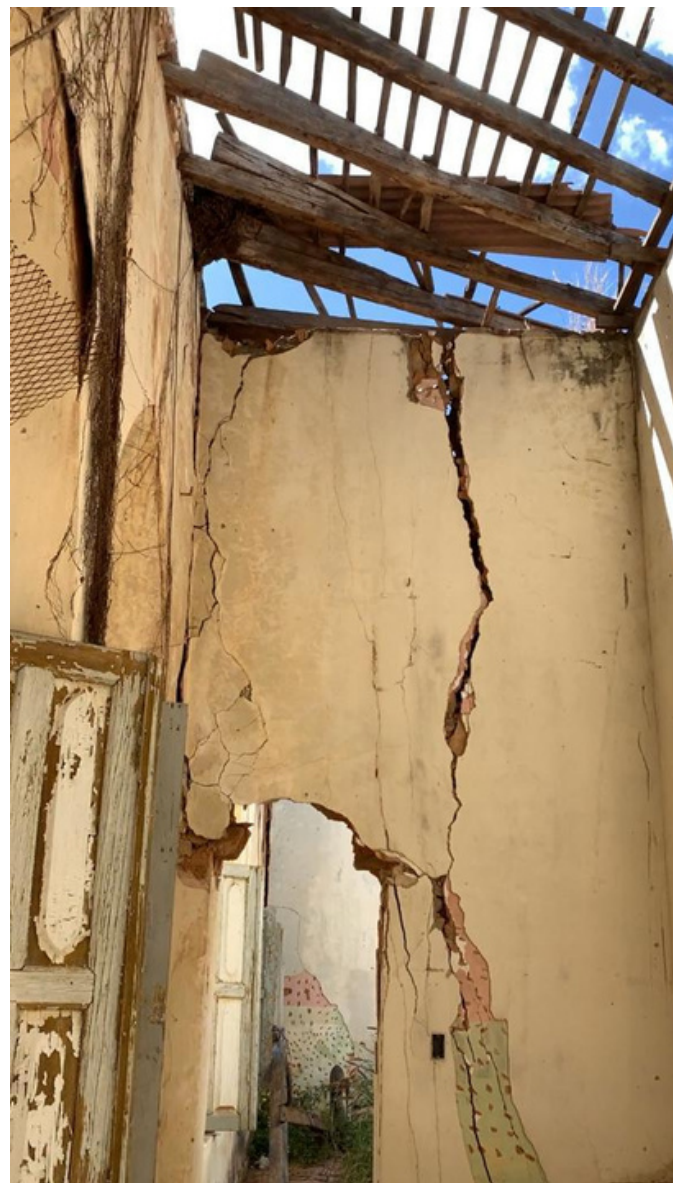
sala G do Abrigo dos Pobres / fonte: Autora, 2021 (figura 82)
