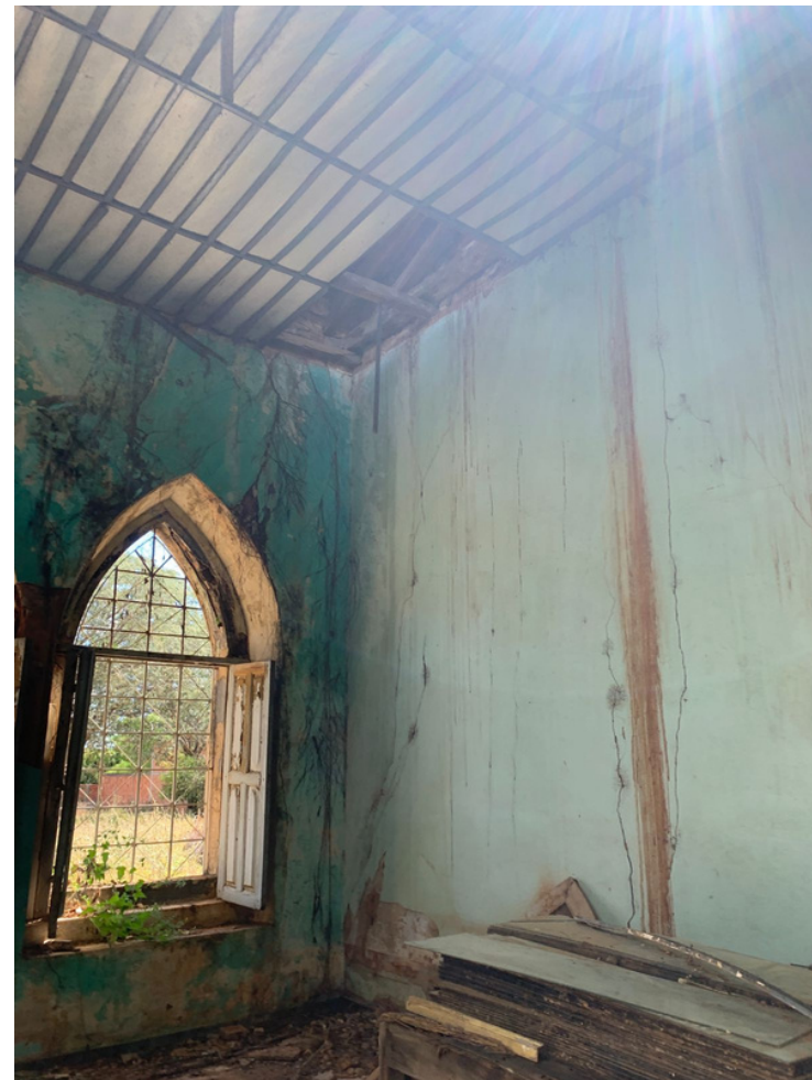
sala L do Abrigo dos Pobres / fonte: Autora, 2021 (figura 90)
