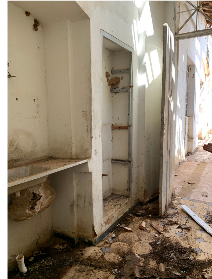
sala a do Abrigo dos Pobres / fonte: Autora ,2021 (figura 55)
