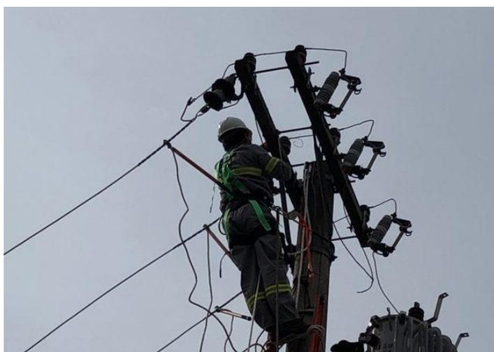
Figura 05. Troca de transformador devido à sobrecarga.
